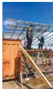
休憩所兼直売所を建設中
