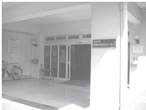
大津市障害者福祉センター
